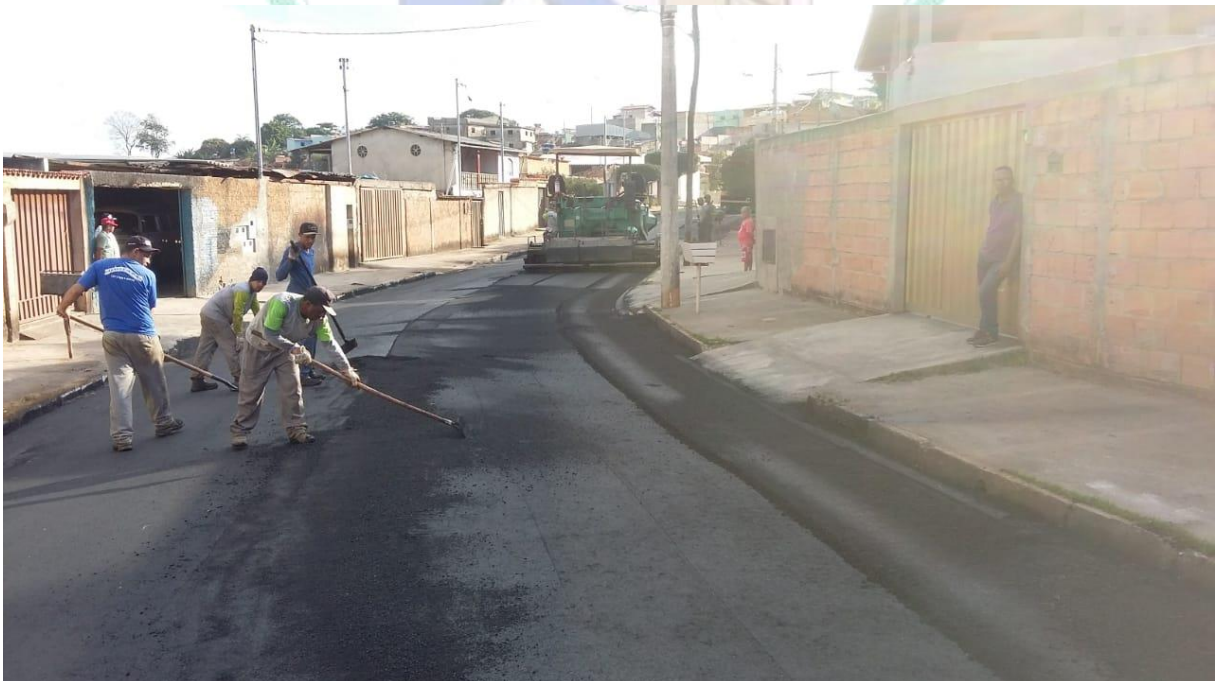
Foto 3 – Aplicação de CBUQ
