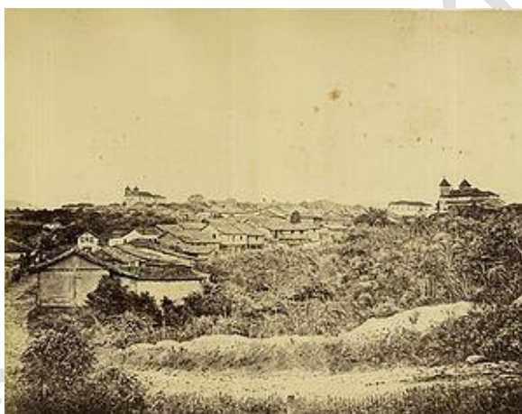
Figura 2 – Vista da primitiva cidade, com destaque à Matriz, Santa Luzia (MG)
