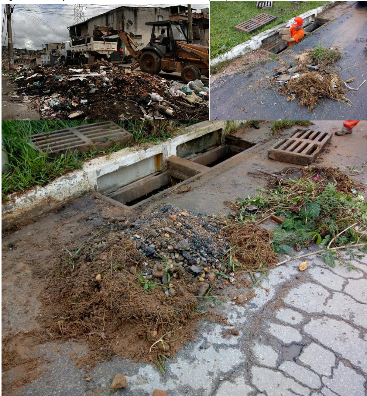
Figura 40 – Limpeza das bocas de lobo, Santa Luzia (MG), 2019
