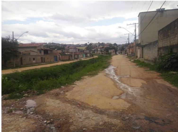
Figura 34 – Foto atual da Avenida Professor Lucas Machado: falta de pavimentação e drenagem urbana
