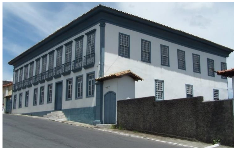
Figura 8 – Solar da Baronesa, Santa Luzia (MG)
