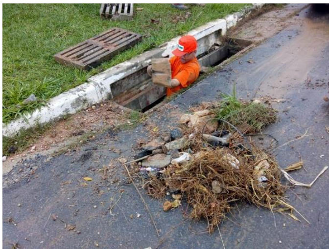
Figura 64 - Limpeza das bocas de lobo, Santa Luzia (MG), 2019
