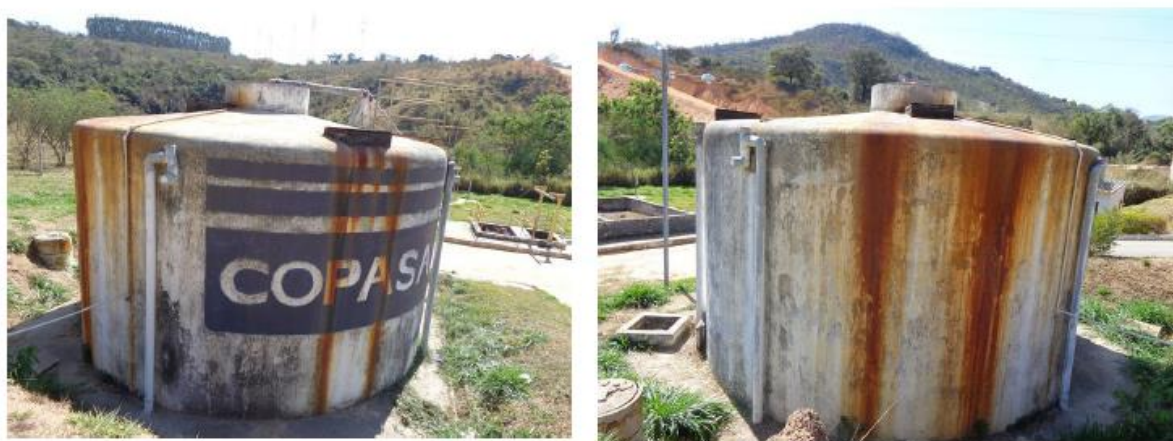
Figura 34 - Reator UASB da ETE- Bom Destino Norte
