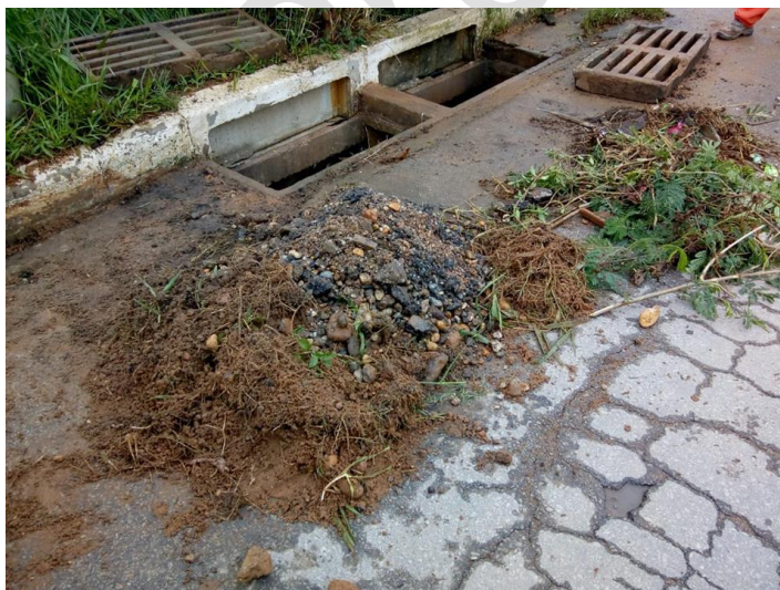
Figura 65 - Limpeza das bocas de lobo, Santa Luzia (MG), 2019
