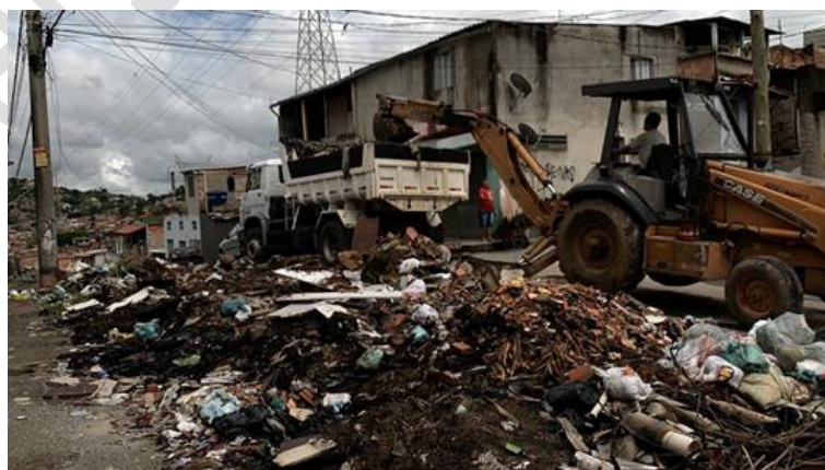
Figura 63 – Limpeza das bocas de lobo, Santa Luzia (MG), 2019
