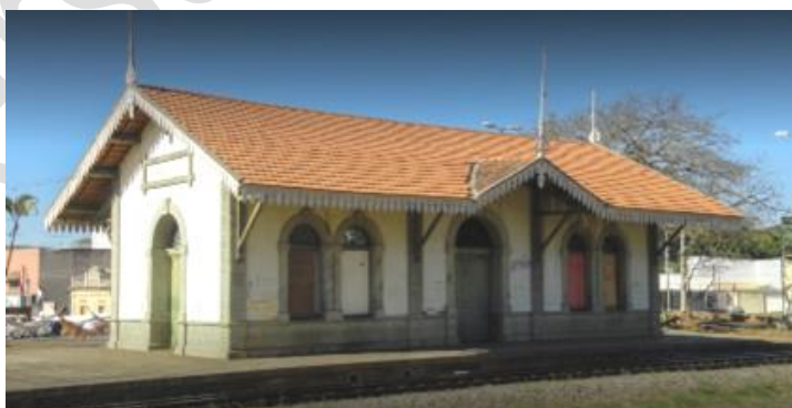
Figura 7 – Estação Ferroviária, Santa Luzia (MG)
