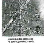
Instalação de acessórios na construção de torres de transmissão
