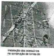
Instalação dos acessórios na construção de torres de transmissão
