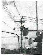
Manutenção realizada utilizando o método ao contato – trabalhador em contato com a rede elétrica, mas isolado
