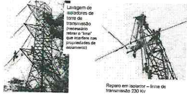
Reparo em isolador – linha de transmissão 230 kv
