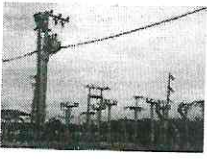
Manutenção em linhas de distribuição desenergizadas
