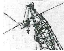
Manutenção executada em "linha viva" de transmissão, método ao potencial (trabalhador com vestimentas condutoras)
