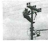
Manutenção em linha de distribuição aérea
