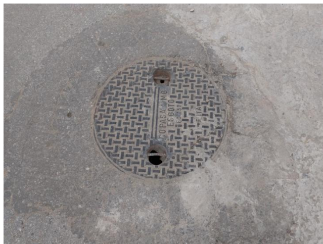
Foto9: Indícios de rede de esgotamento sanitário na R. Juqueri.
