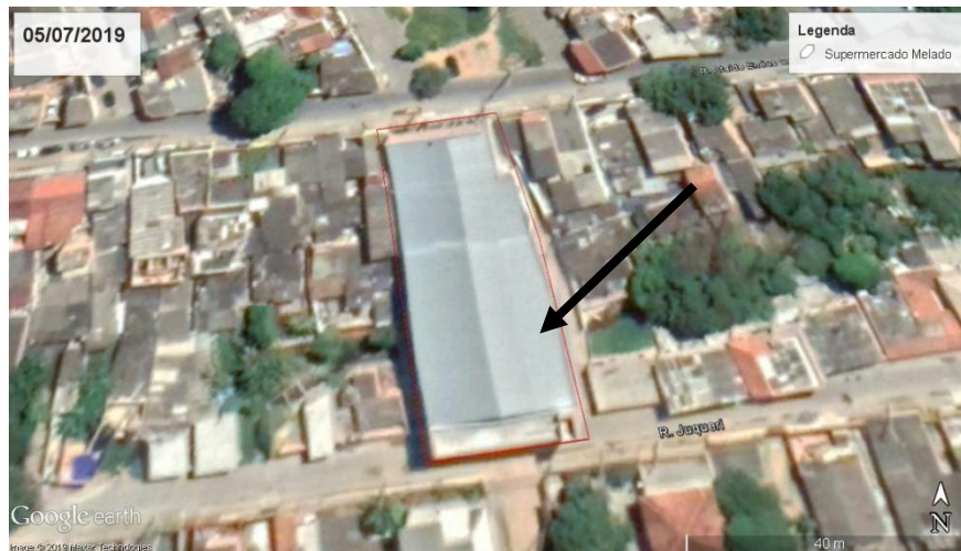
Foto5: Histórico de construção do empreendimento enfatizando a supressão arbórea em Área de Preservação Permanente.
