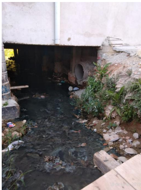
Foto2: Galeria feita pelo Sr. Celson por onde passa o curso d'água embaixo do empreendimento.
