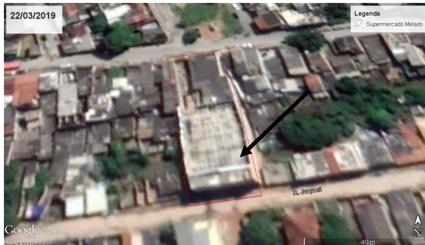
Foto4: Histórico de construção do empreendimento enfatizando a supressão arbórea em Área de Preservação Permanente.
