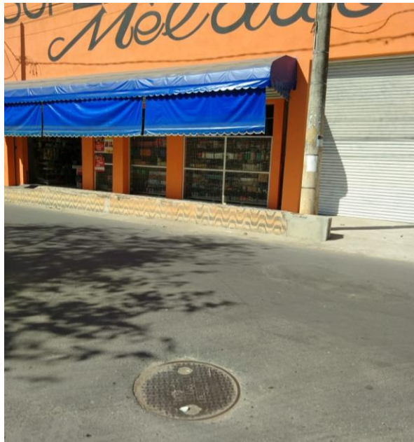
Foto9: Indícios de rede de esgotamento sanitário na R. Ataíde Enéias Orzil.
