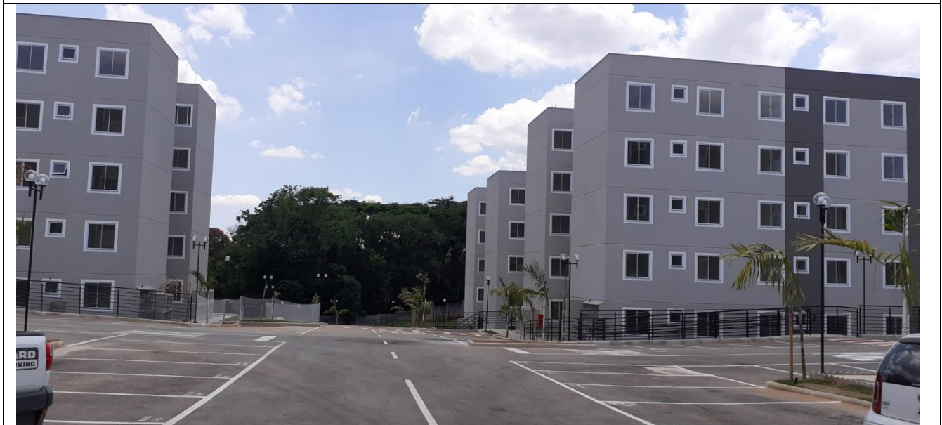
Imagem3: Vista do estacionamento e dos blocos.
