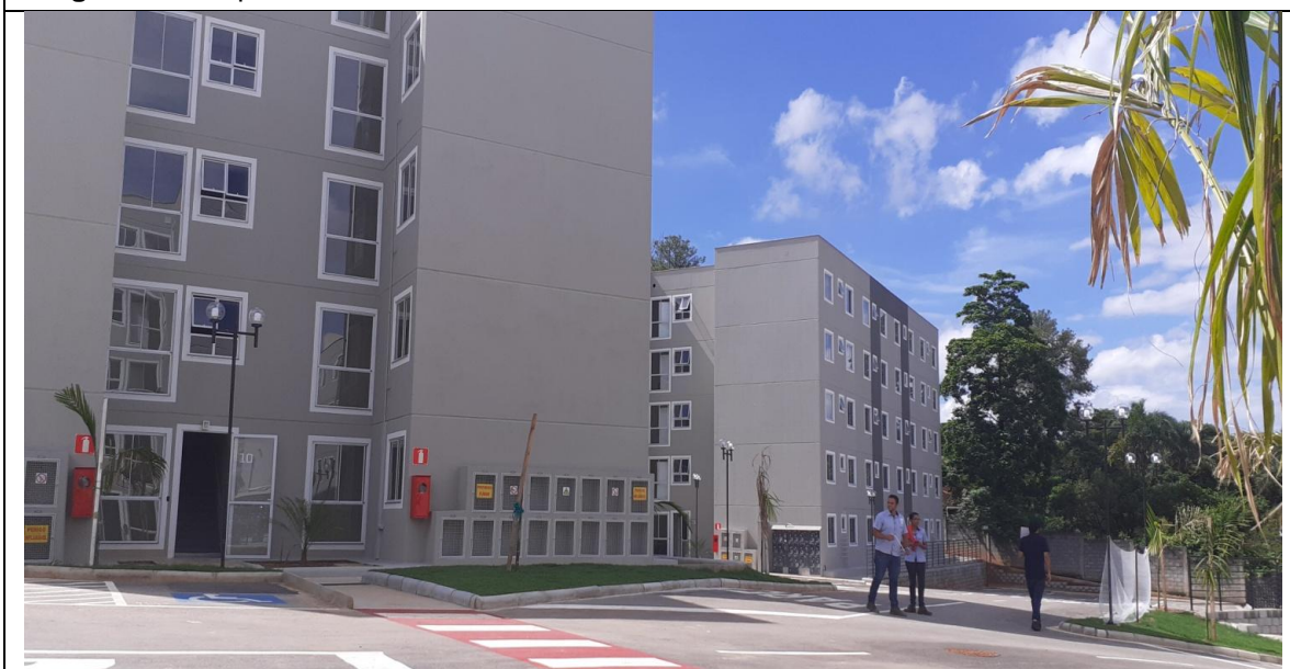
Imagem3: Vista parcial dos dois blocos concluídos.
