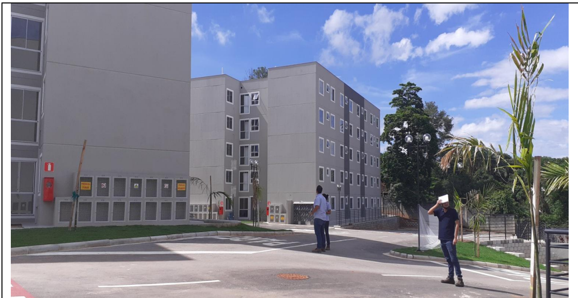
Imagem2: Vista parcial dos dois blocos concluídos.
