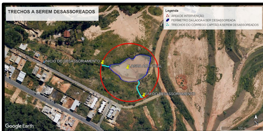
Figura 02: Vista aérea dos trechos do Córrego Capitão e da lagoa artificial
