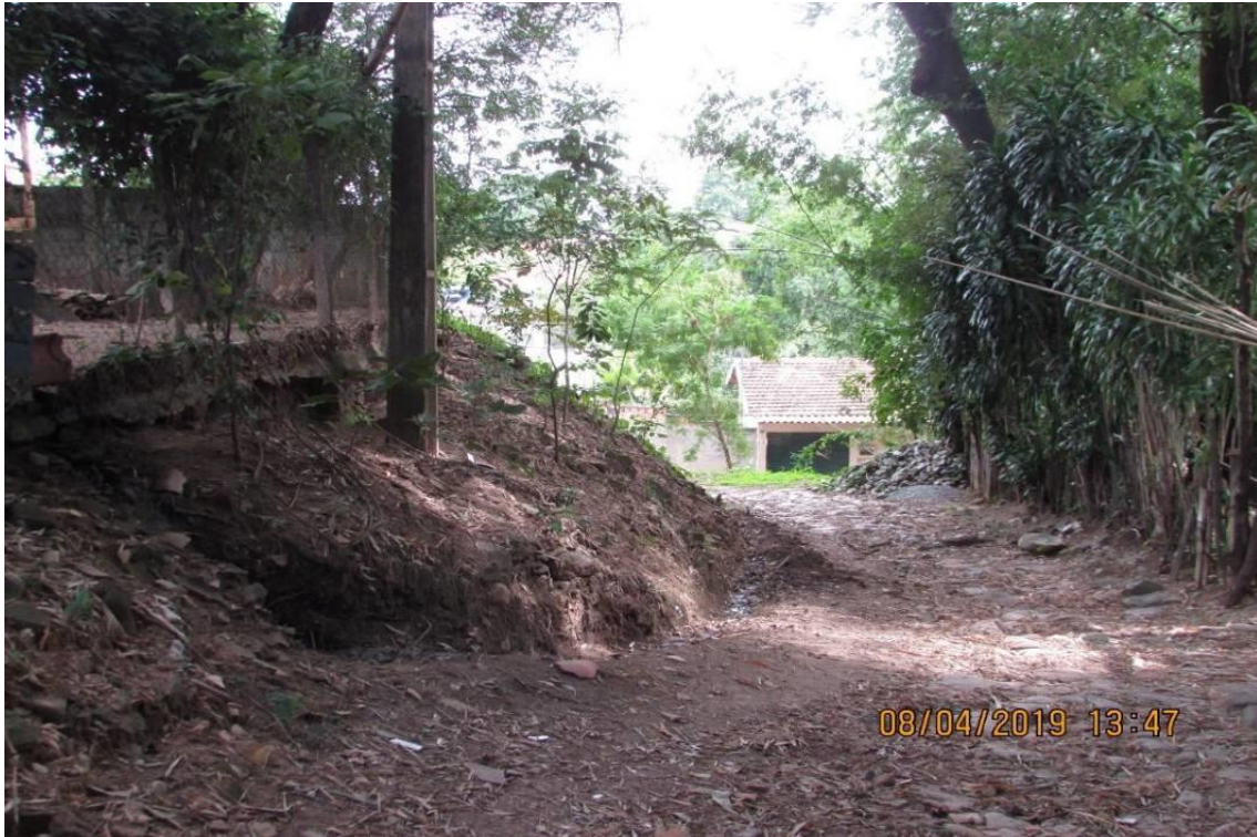
Imagem 4: Talude com o solo degradado, sujeira, escoamento do esgoto a céu aberto, no lado esquerdo da imagem. Fonte: Ana Paula Viana Reis, 08/04/2019.
