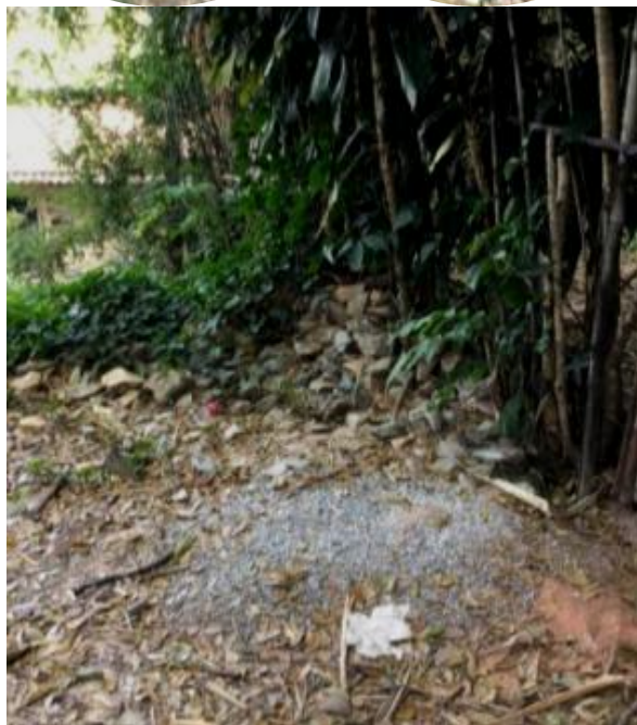
Figura 33 – Saída do Beco do Bonfim com vista para a Rua Olímpia dos Santos/Santa Luzia/MG. Fechamento com vegetação com cercamento bem denso, predominando a espécie dracena Dracaena fragrans . Lupa1: sujeidade no local, acúmulo de pedras poliédricas, seixo rolado, vegetação forrageira singônio Singonium podophyllum sobre o entulho; lupa 2: britas e sujeidade.
