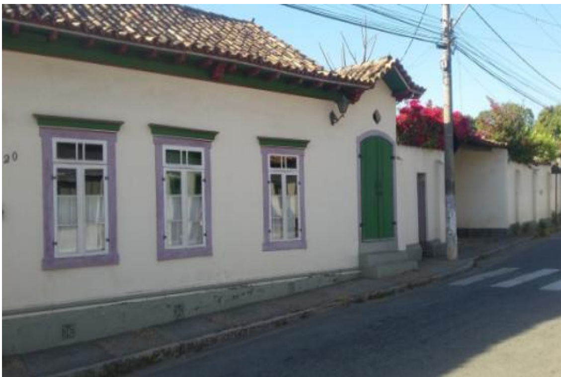
Figura 08 – Fachada da casa do Barão de Catas Altas, morador do século XVIII, na Rua Silva Jardim/Santa Luzia/MG, em frente ao Beco do Bonfim. Fonte: Márcia Souza; 22/07/2020.
