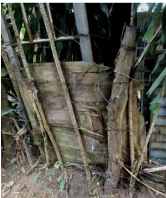
Figura 32 – Cercamento com esteios de madeira com vestígio de xilófagos com brocas apodrecidas, com cinco fiadas de arame, fechamento com parte de grade oxidada e compensado danificados. Fonte: Márcia Souza, 22/07/2020.
