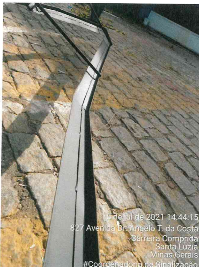
Figura : Destaque para peça empenada
