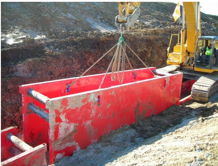
Figura 1 – Escoramento metálico do tipo blindagem (atestado exigido) – imagens ilustrativas do método de colocação do módulo
