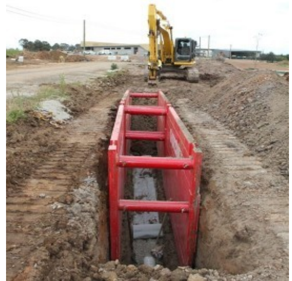
Figura 1 – Escoramento metálico do tipo blindagem (atestado exigido) – imagens ilustrativas do método de colocação do módulo
