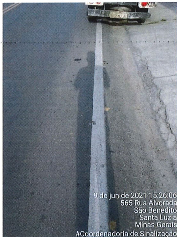
Figura 10: Fotografia do mesmo trecho no dia 09 de junho de 2021, pouco mais de 1 mês depois da sinalização – Destaque para a linha de bordo desgastada
