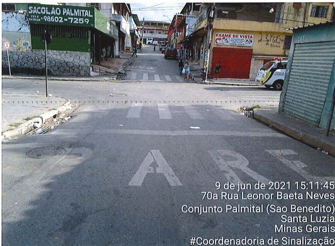
Figura 6: Fotografia do mesmo local no dia 09 de junho de 2021, menos de 1 mês depois da implantação da sinalização – Destaque para as faixas de pedestres quase apagadas, bem como a legenda de PARE e linhas de retenção desgastadas
