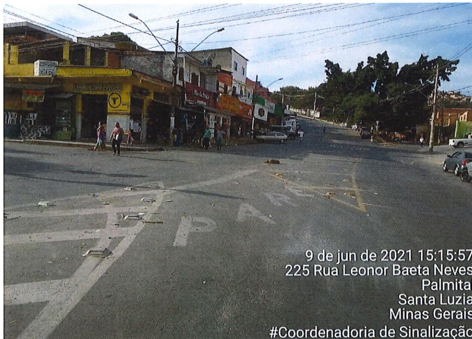
Figura 2: Fotografia do mesmo local no dia 09 de junho de 2021, menos de 1 mês depois da implantação da sinalização. Nota-se os zebraços bem apagados (branco e amarelo), bem como a legenda de PARE e a linha de retenção
