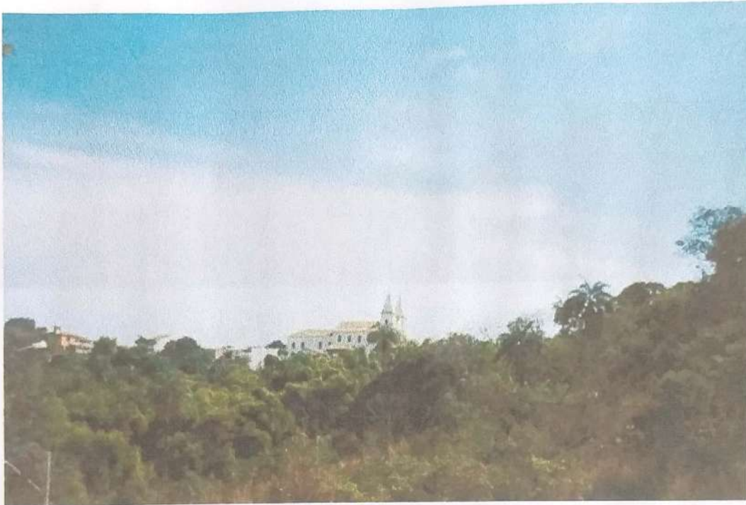
FOTO 7: Igreja Matriz de Santa Luzia: fachada lateral esquerda.
