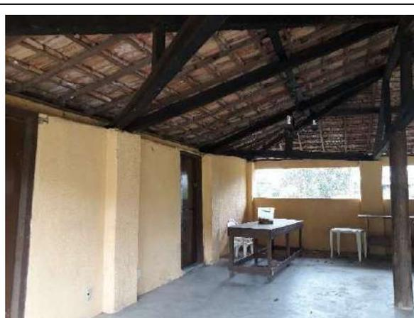
**Foto 32:** Pilares de alvenaria embutidos na parede interna que faz a divisa entre o salão e os compartimentos.
