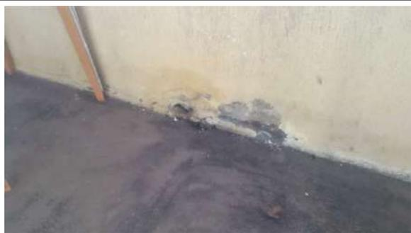
**FOTO 29:** Mancha provavelmente oriunda de infiltração na base da parede interna do salão
