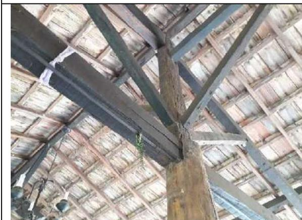
**Foto 33:** Detalhe dos travamentos entre as peças de madeira da estrutura na cobertura.
