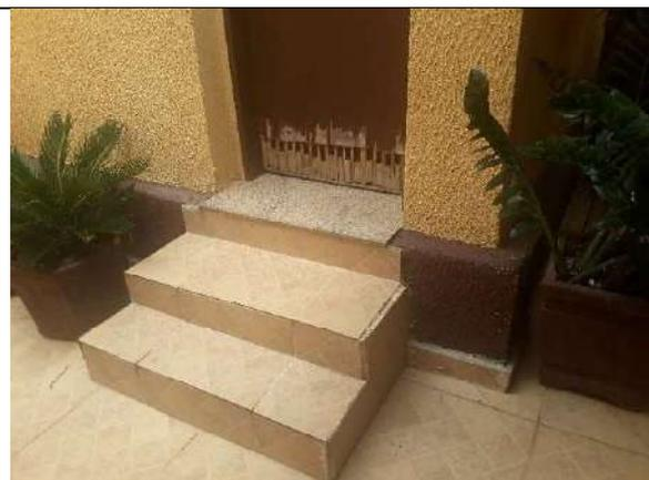
**Foto 58:** Escada de acesso à porta lateral, com destaque para a massa de textura da parede. Perda de elementos na porta de acesso secundária a capela.
