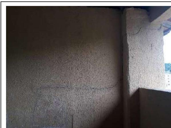
**Foto 31:** Trinca ao longo da parede, avançando no pilar estrutural situado aos fundos da construção.
