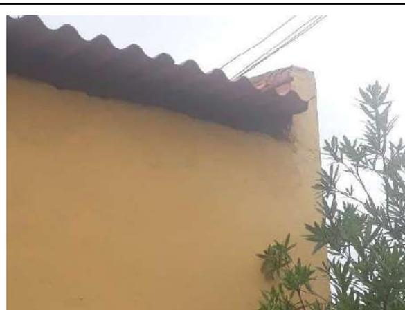
**Foto 56:** Beiral curto da cobertura provida de telhas do tipo ondulada, com uma água.
