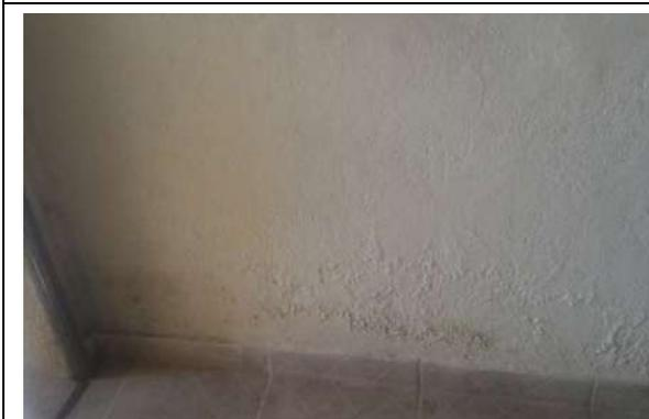
**FOTO 39:** Alvenaria com presença de eflorescências.
