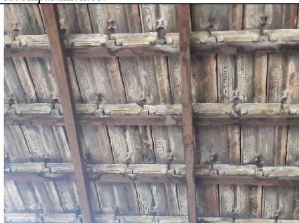
**Foto 34:** Detalhe da trama reticulada do telhado, com telhas francesas apoiadas sobre o ripamento.
