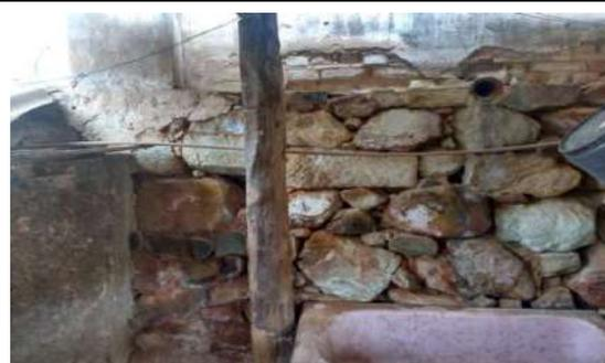
**FOTO 24:** Detalhe do alicerce aparente de pedras em junta seca no restante da fachada posterior.
