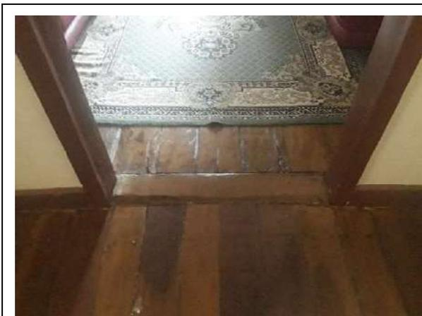
**FOTO 41:** Piso de tábuas finas resultante de provável substituição das peças originais.
