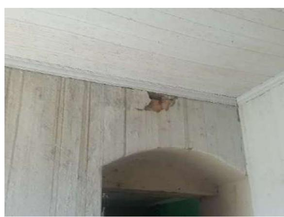
**FOTO 44:** Forro de PVC e revestimento deteriorado na parede da casa do caseiro.
