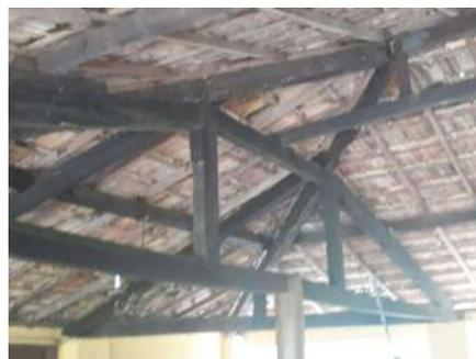
**FOTO 22:** Madeiramento do telhado agrega peças originais de aroeira ou eucalipto de tratamento rústico (provavelmente desdobradas a machado), com outras novas em substituição às mais antigas.
