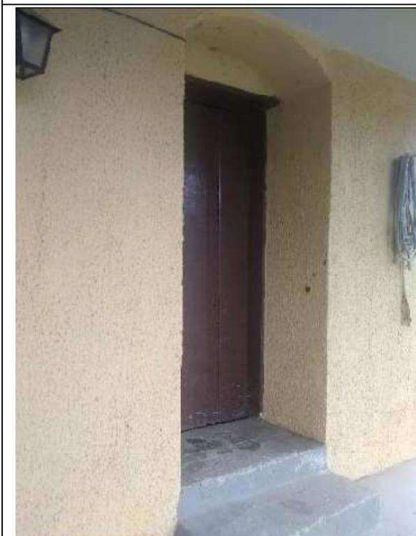
**Foto 49:** Detalhe da verga arqueada aparente na parede externa que não coincide com a verga reta interna.
