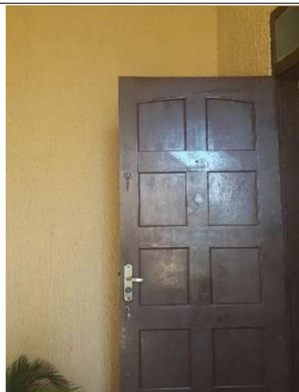
**Foto 50:** Detalhe da porta almofadada de acesso à cozinha que substitui o modelo original.
