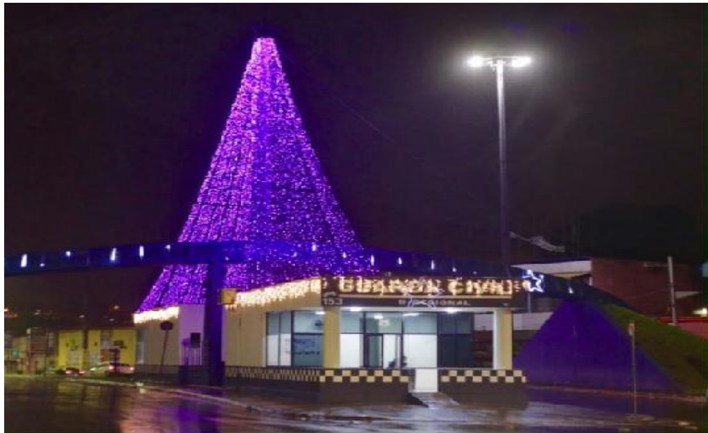
Imagem 04 – PORTAL - ARCO E GUARITA - Imagem meramente ilustrativa
