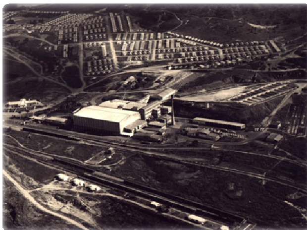
FIGURA 05 – Vista aérea do Frigorífico FRIMISA, ao fundo o Conjunto Habitacional Carreira Comprida, década de 1970.
