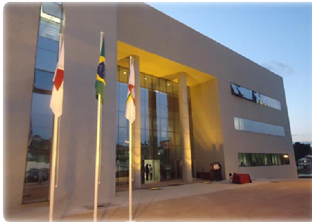
FIGURA 07 – Novo Fórum da Comarca de Santa Luzia inaugurado em 2012.
