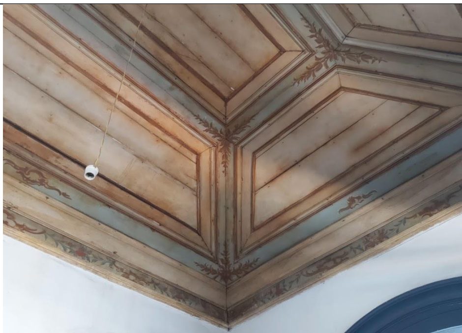
Detalhe do forro de gamela da Sala 19.
