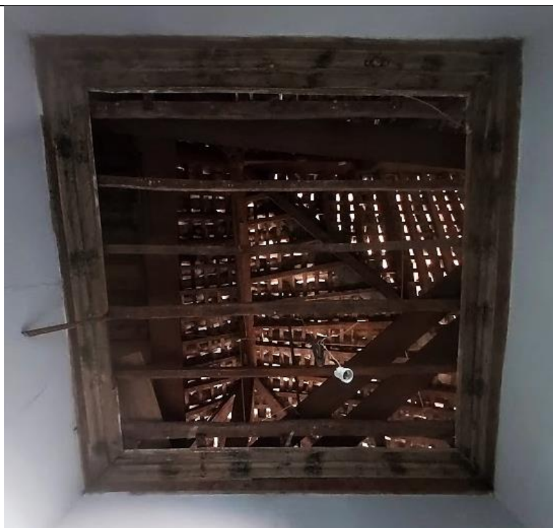
Aspecto atual do forro e da cimalha da sala 16.
