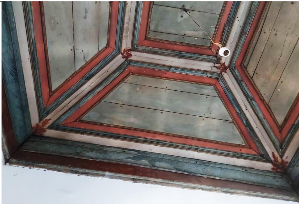
Detalhe do forro de gamela da Sala 14.
