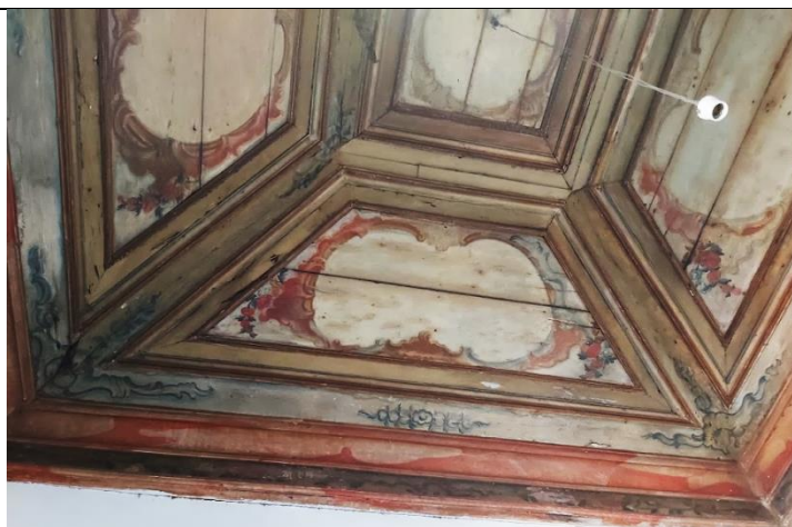
Detalhe do forro de gamela da Sala 01.
