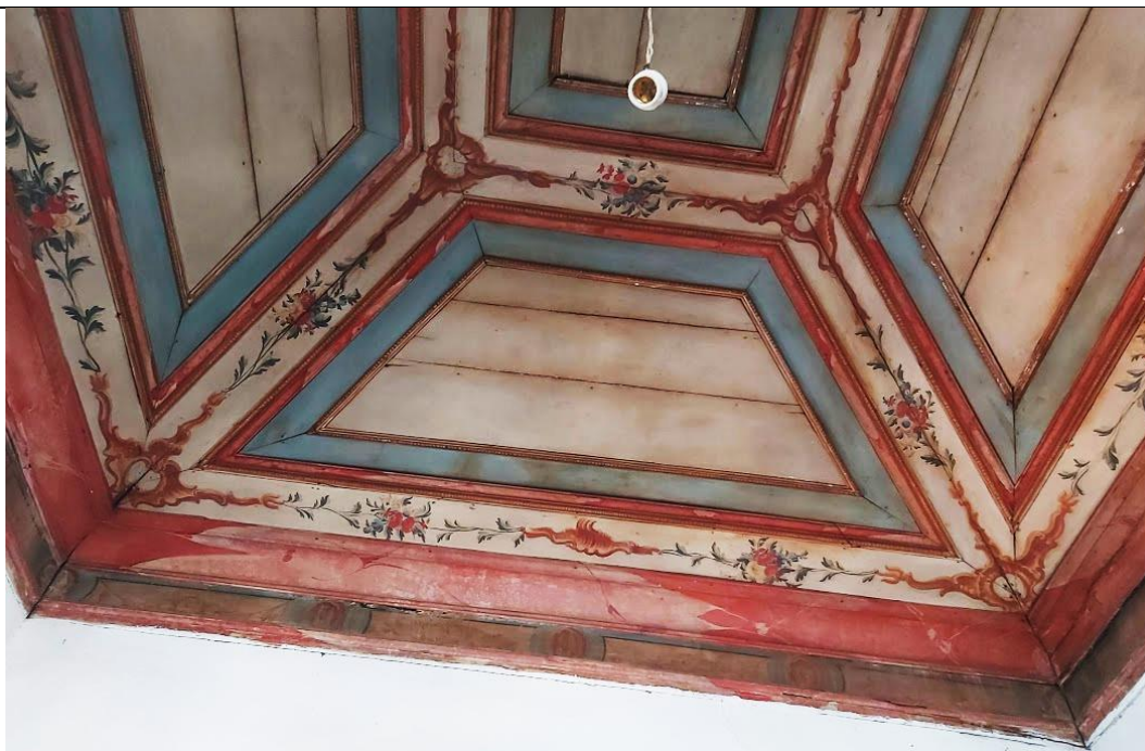
Detalhe do forro de gamela da Sala 18.
