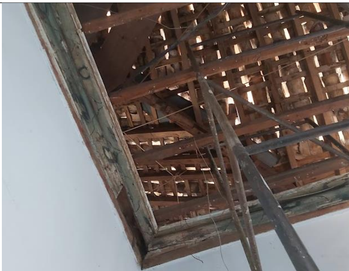
Detalhe do forro de esteira e cimalha da sala 17.
