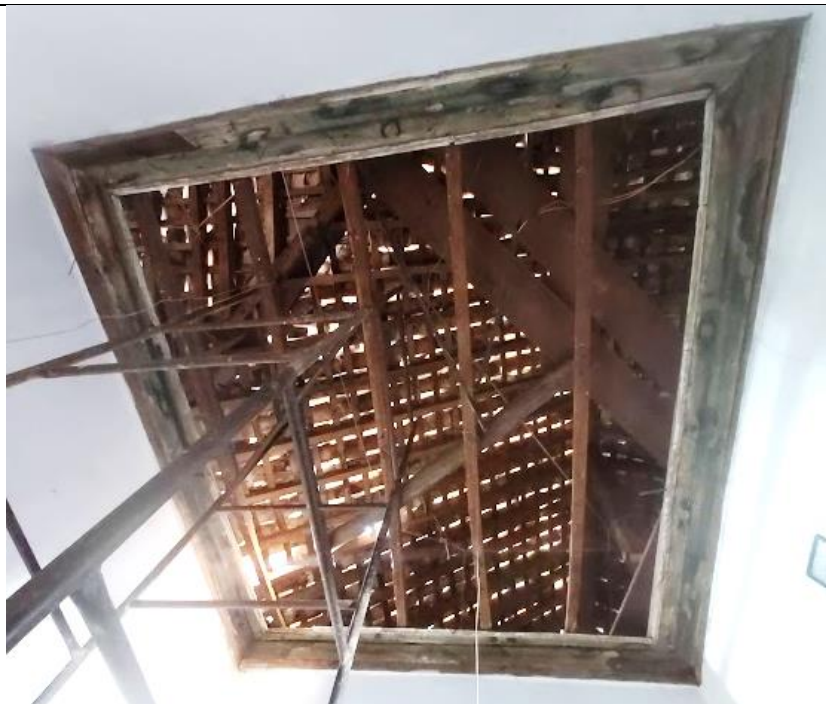
Aspecto atual do forro e da cimalha da sala 17.
