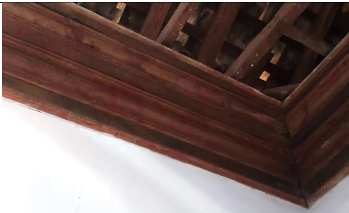
Detalhe do forro de esteira e cimalha da sala 13.
