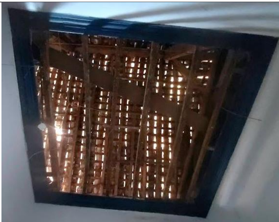
Aspecto atual do forro e da cimalha da sala 10.
