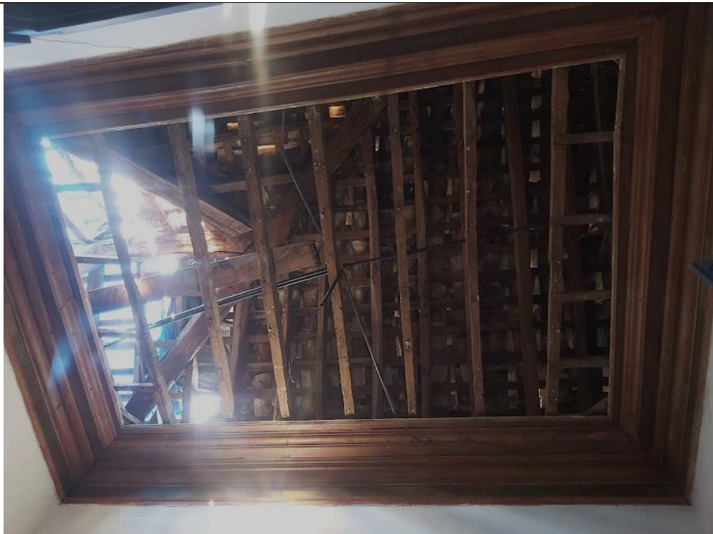
Detalhe dos caibros que sustentam a esteira do forro da Sala 13.
