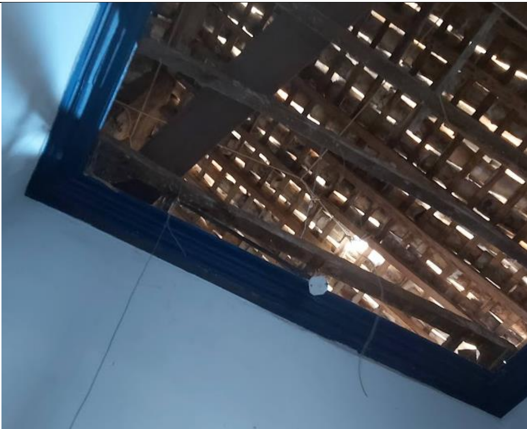
Detalhe do forro de gamela da Sala 10.
