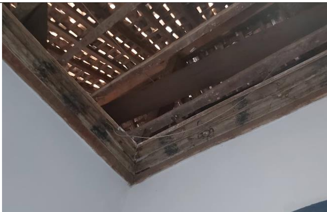
Detalhe do forro de esteira e cimalha da sala 16.
