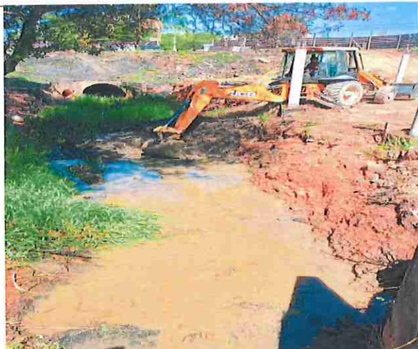
Foto. 17: Remorção de material e descarte em caminhão
