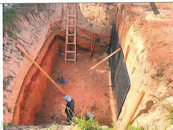
Foto. 9: Forma de externa casa de bombas
