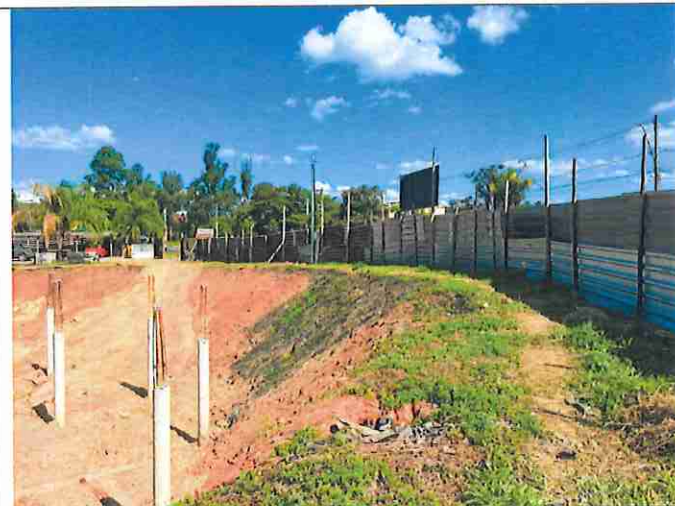
Foto. 10: Tapume de obra
