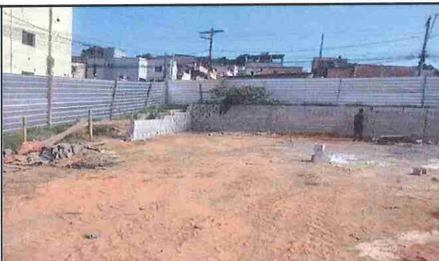
Foto. 8: Item 1.4 - Muros de Arrimo Quadra Palmital
