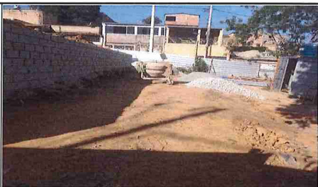
Foto. 2: Item 1.4 - Muros de Arrimo Quadra Palmital
