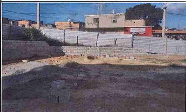
Foto. 3: Item 1.4 - Muros de Arrimo Quadra Palmital
