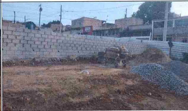
Foto. 10: Item 1.4 - Muros de Arrimo Quadra Palmital
