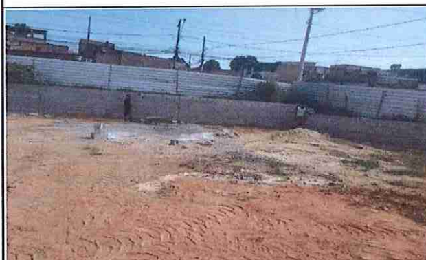
Foto. 9: Item 1.4 - Muros de Arrimo Quadra Palmital
