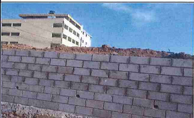
Foto. 5: Item 1.4 - Muros de Arrimo Quadra Palmital
