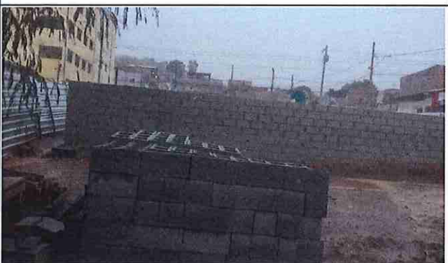
Foto. 6: Item 1.4 - Muros de Arrimo Quadra Palmital
