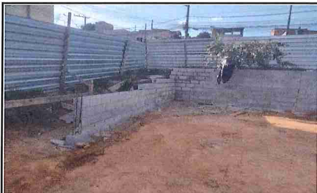
Foto. 1: Item 1.4 - Muros de Arrimo Quadra Palmital
