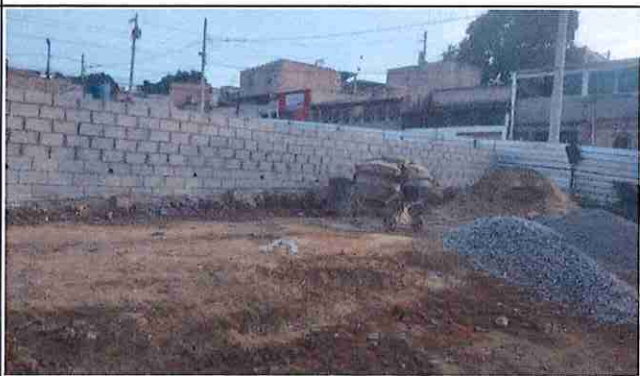
Foto. 4: Item 1.4 - Muros de Arrimo Quadra Palmital
