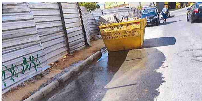
Foto. 25: Demolição de Passeio
