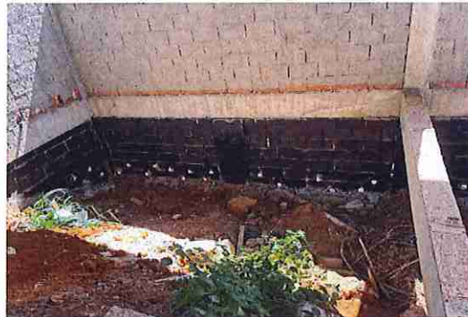
Foto. 26: Concretagem viga Subsolo
