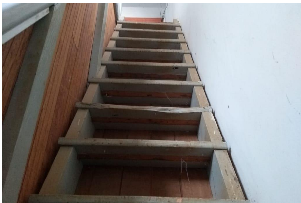
Imagem 30: Escada de acesso a mezanino da Capela Santo Antônio–Ribeirão da Mata Fonte: Secretaria Municipal de Cultura e Turismo – Santa Luzia/MG. Data: 22/10/2020
