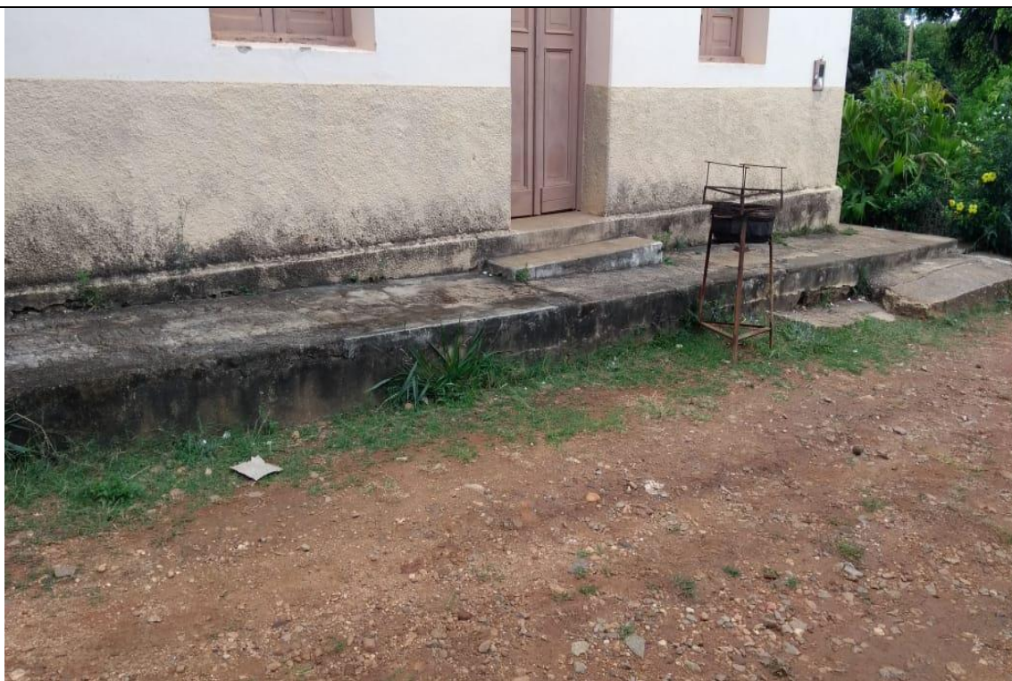
Imagem 13: Escada de acesso à lateral direita da Capela Santo Antônio – Ribeirão da Mata Fonte: Secretaria Municipal de Cultura e Turismo – Santa Luzia/MG. Data: 22/10/2020
