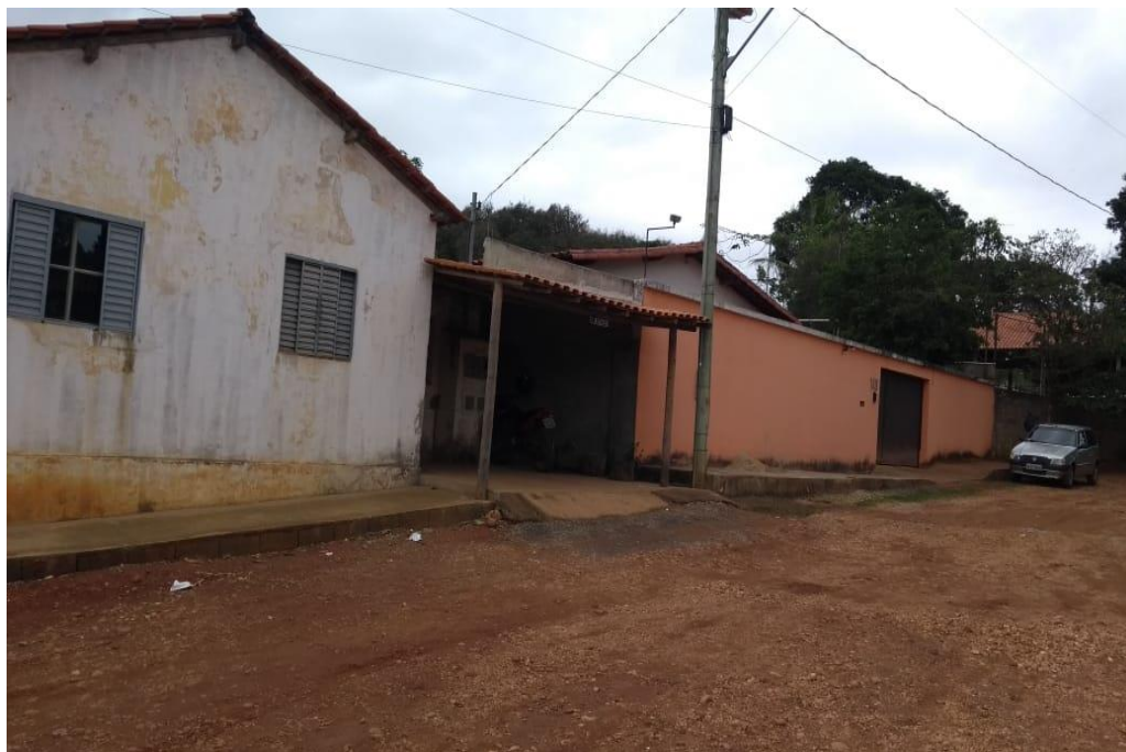
Imagem 6: Edificações entorno Capela Santo Antônio – Ribeirão da Mata Fonte: Secretaria Municipal de Cultura e Turismo – Santa Luzia/MG. Data: 22/10/2020
