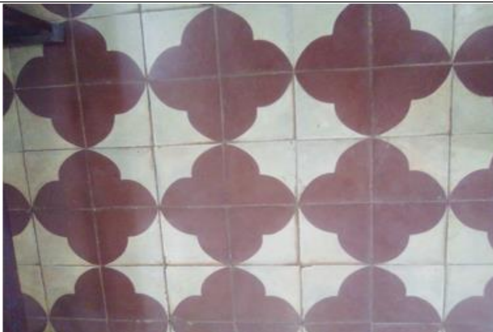
Imagem 31: Piso Interno da Capela Santo Antônio–Ribeirão da Mata Fonte: Secretaria Municipal de Cultura e Turismo – Santa Luzia/MG. Data: 22/10/2020
