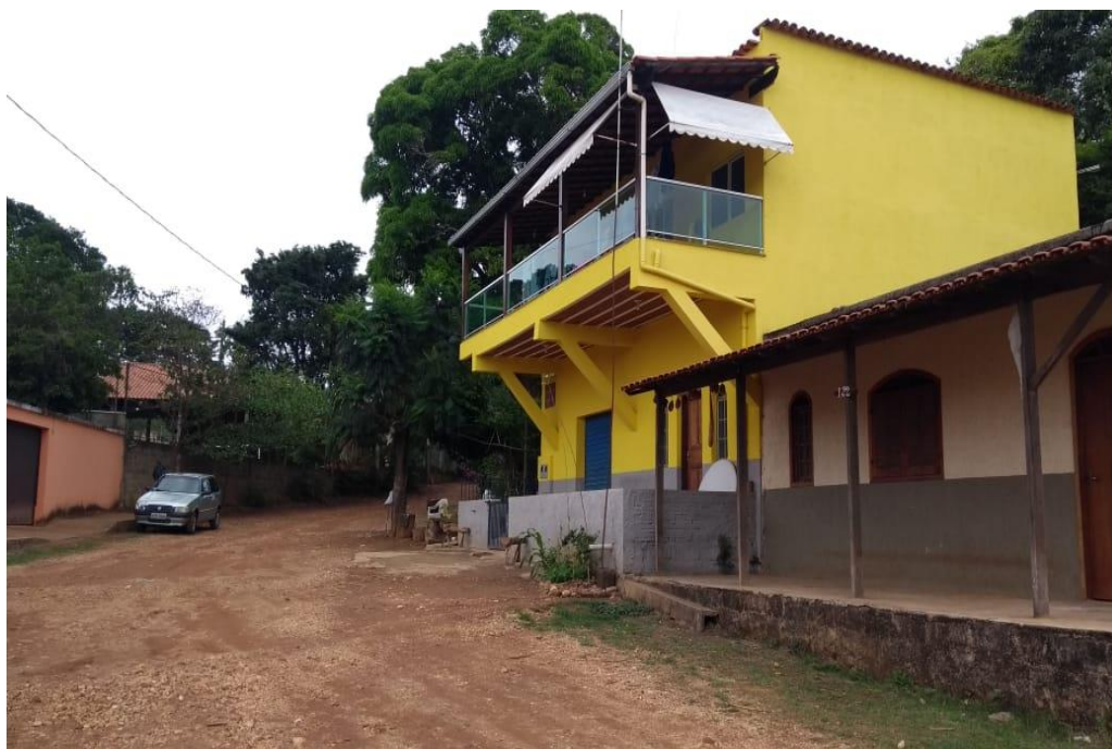
Imagem 5: Edificação de dois pavimentos – Ribeirão da Mata Fonte: Secretaria Municipal de Cultura e Turismo – Santa Luzia/MG. Data: 22/10/2020
