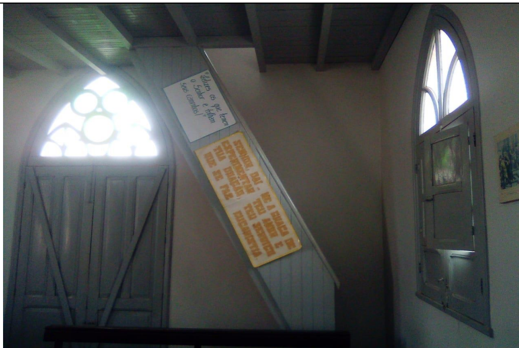
Imagem 29: Vista escada de acesso a mezanino da Capela Santo Antônio–Ribeirão da Mata Fonte: Secretaria Municipal de Cultura e Turismo – Santa Luzia/MG. Data: 22/10/2020
