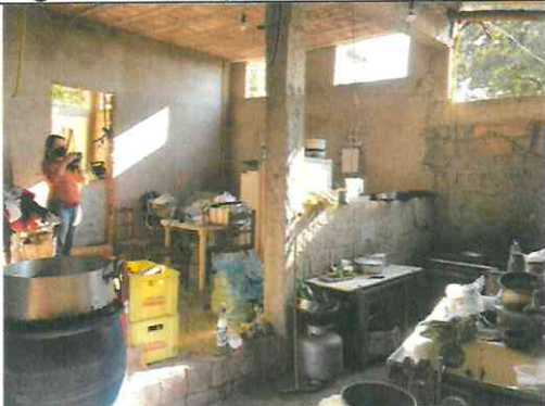
Figura 5. Edificação 02 existente no local
