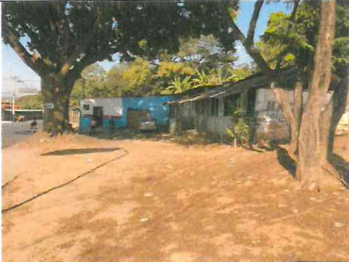
Figura 1. Edificações existentes no local objeto da avaliação
