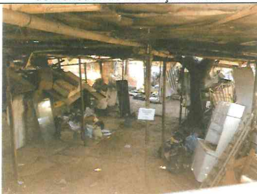
Figura 10. Área de sucata sem acesso na vistoria
