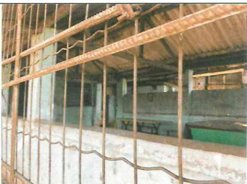
Figura 9. Edificação 04 existente no local sem acesso na vistoria
