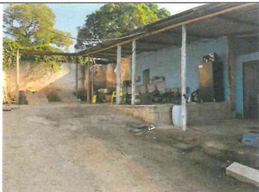
Figura 7. Edificação 03 existente no local
