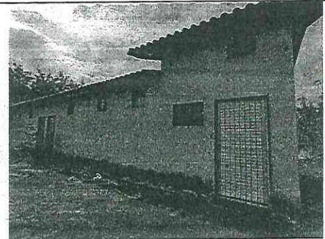
Figura 12. Frente do vestiário.
