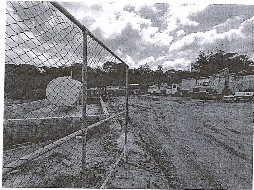
Figura 3 – Vista interna do Local
