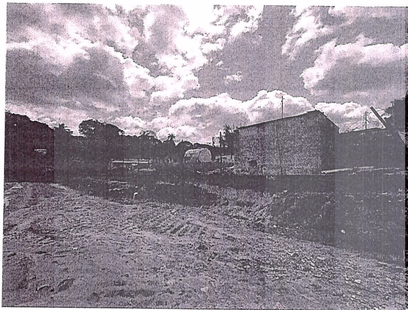
Figura 1 – Fachada Av. Professor Lucas Machado
