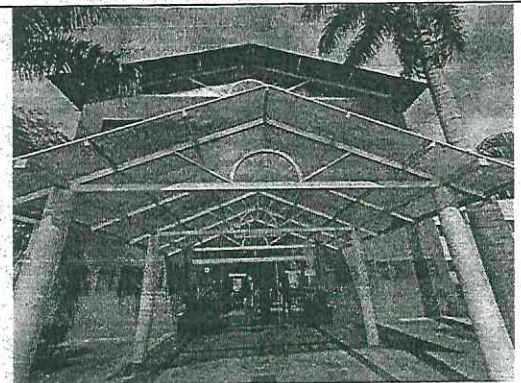
Figura 16. Entrada principal com cobertura em policarbonato.
