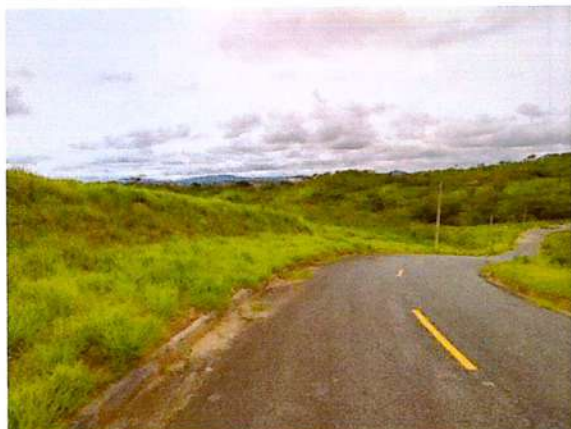
Foto 13. Visada da quadra 25 na altura dos lotes 34 e 35 na Rua Helena Soares Viana. Aclive leve notado e cabos de energia entre os postes cortados.
