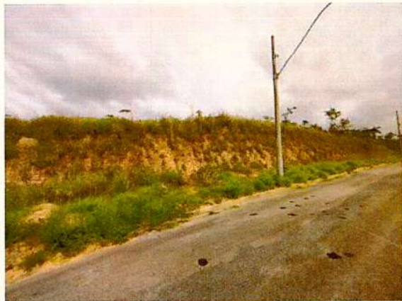
Foto 3. Visada da quadra 25 na altura dos lotes 19/20 da Rua Moacir Mundim. Aclive notado e cabos de energia entre os postes cortados.
