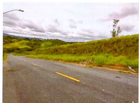
Foto 8. Visada da quadra 25 na altura dos lotes 5 e 6 na esquina na Avenida Selma Maria da Silva. Aclive notado e cabos de energia entre os postes cortados.
