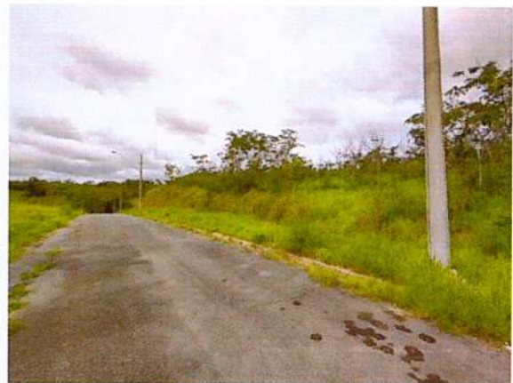
Foto 6. Visada da quadra 25 na altura dos lotes 12 e 13 da Rua Moacir Mundim. Aclive leve notado e cabos de energia entre os postes cortados.
