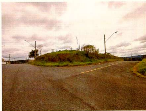
Foto 11. Visada da quadra 25 na altura do lote 1 na esquina entre a Avenida Décio Araújo e a Rua Helena Soares Viana. Aclive notado e cabos de energia entre os postes cortados.
