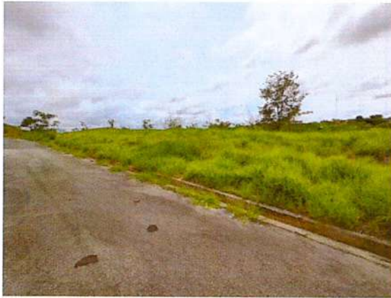
Foto 5. Visada da quadra 26 na altura do lote 15 da Rua Moacir Mundim. Cabos de energia entre os postes cortados.
