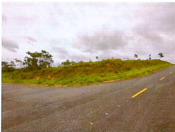
Foto 7. Visada da quadra 25 na altura dos lotes 9 e 10 na esquina entre a Rua Moacir Mundim e a Avenida Selma Maria da Silva. Aclive notado e cabos de energia entre os postes cortados.
