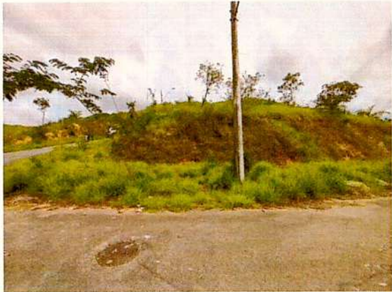
Foto 1. Visada da quadra 26 na altura do lote 14, na curva da Rua Moacir Mundim. Aclive notado e cabos de energia entre os postes cortados.
