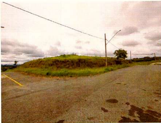
Foto 9. Visada da quadra 25 na altura do lote 3 na esquina entre a Avenida Décio Araújo e a Avenida Selma Maria da Silva. Aclive leve notado.
