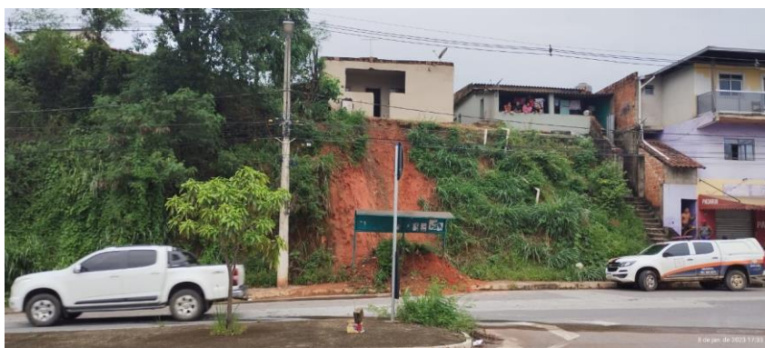
06 - Deslizamento de Talude na Rua Doutor Cassiano Augusto Oliveira Lima Nº 522;
