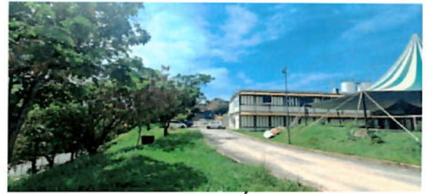
Figura 74. Visada Área externa.
