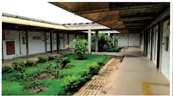
Figura 68. Circulação Bloco C.
