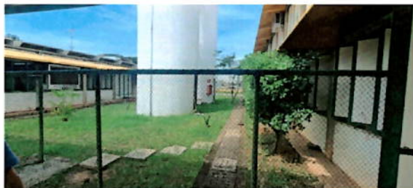
Figura 25. Área externa, reservatórios.
