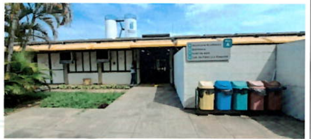
Figura 12. Bloco A, acesso.
