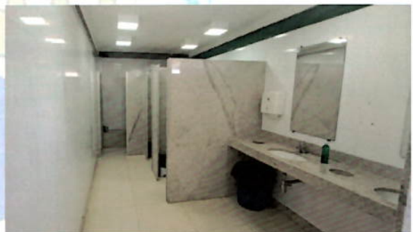
Figura 30. Sanitário Feminino Servidores.
