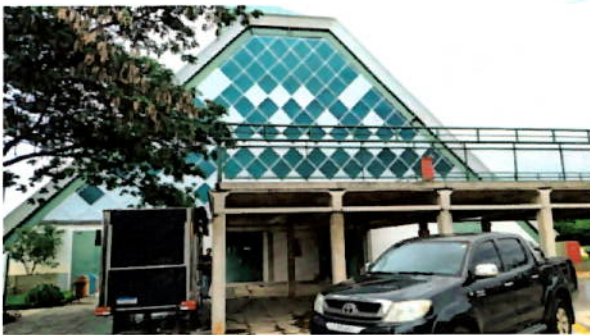
Figura 47. Área externa, quadra poliesportiva.
