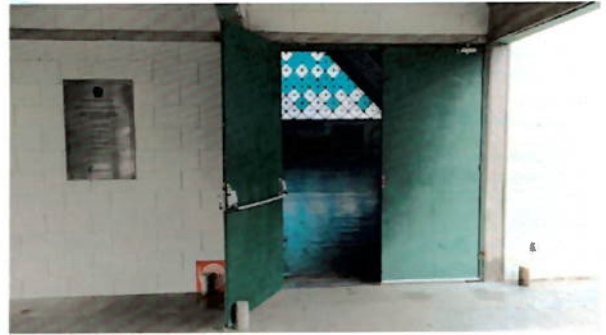
Figura 48. Acesso quadra poliesportiva.
