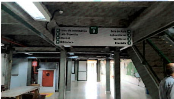
Figura 45. Bloco B. Área de circulação.
