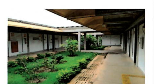
Figura 64. Área Interna Bloco C
