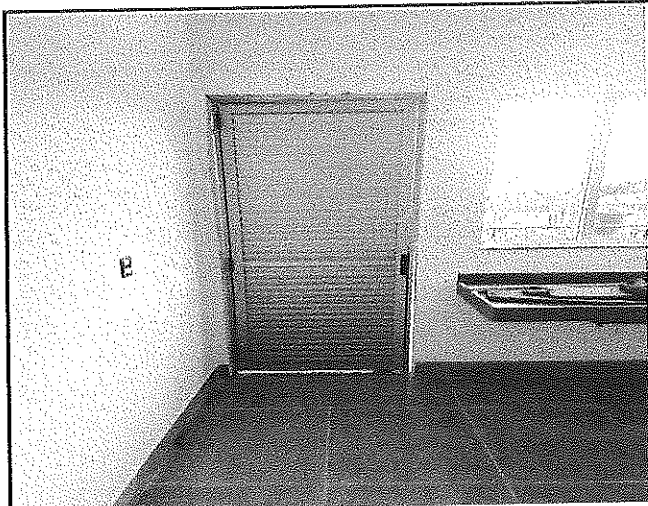
Foto 7: Instalação de porta de alumínio
