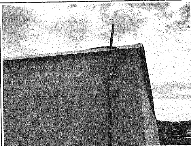
Foto 8: Instalação de SPDA
