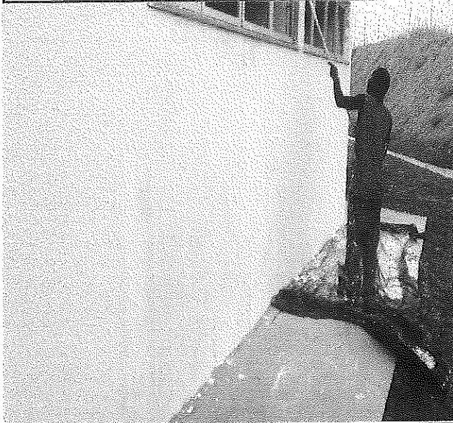
Foto 1: Aplicação de fundo selador
