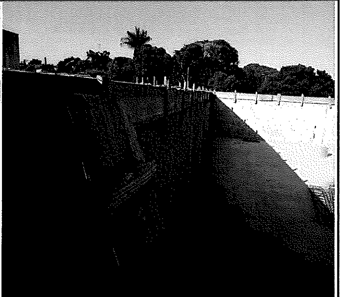
ARMAÇÃO DE PILAR OU VIGA DE UMA ESTRUTURA CONVENCIONAL DE CONCRETO ARMADO EM UMA EDIFICAÇÃO TÉRREA OU SOBRADO UTILIZANDO AÇO CA-60 DE 5,0 MM - MONTAGEM. AF_12/2015
