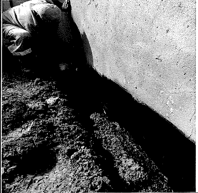
IMPERMEABILIZAÇÃO DE SUPERFÍCIE COM EMULSÃO ASFÁLTICA, 2 DEMÃOS AF_06/2018 (Conforme valor do item 5.2.12)
