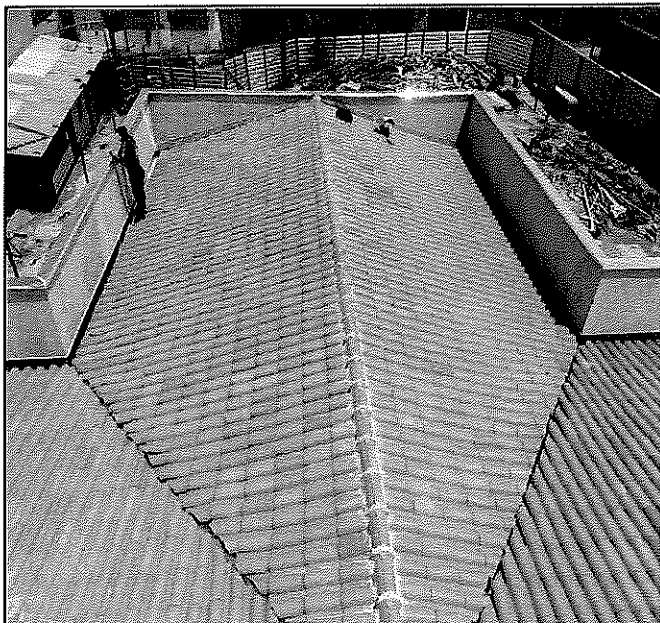
RINÇAO PARA ESCOAMENTO DE AGUAS PLUVIAIS EM COBERTURA
