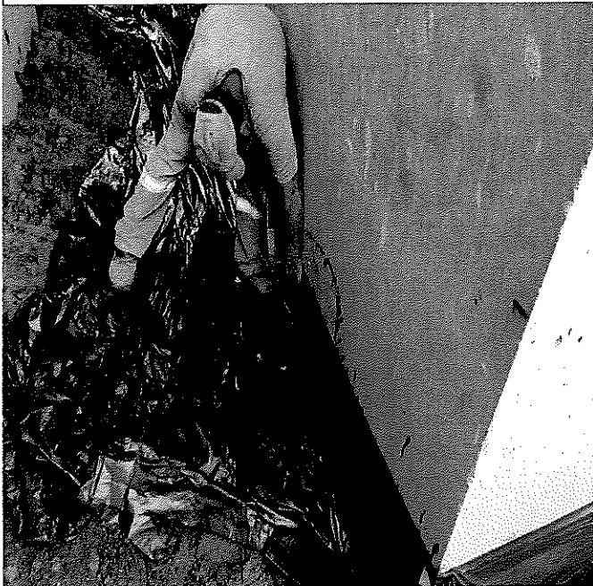
APLICAÇÃO DE LONA PRETA, ESP. 150 MICRAS, INCLUSIVE FORNECIMENTO
