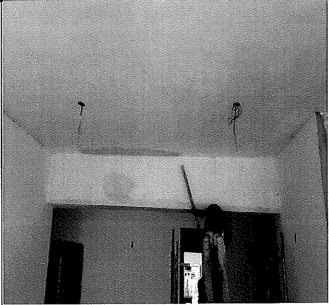
APLICAÇÃO MANUAL DE GESSO DESEMPENADO (SEM TALISCAS) EM TETO DE AMBIENTES DE ÁREA ENTRE 5M² E 10M², ESPESSURA DE 1,0CM. AF_06/2014
